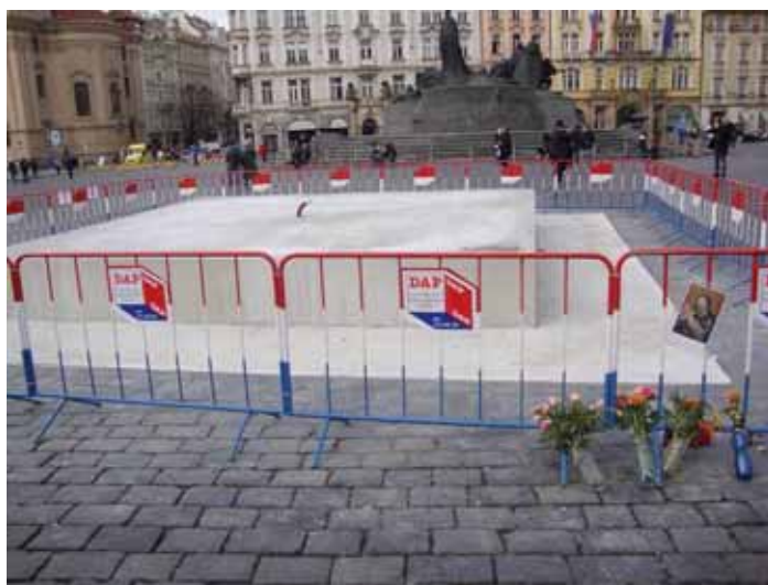
Základová deska mariánského sloupu
