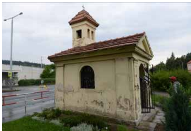
Stav kaple před opravou
